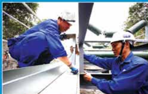
Thi công Lắp đặt tuyến băng tải vận chuyển than Lep My đi cảng km6 - Cẩm Phả.
